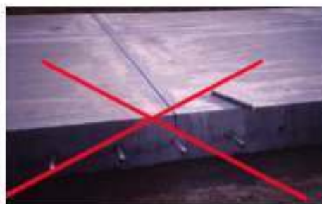
Ubicación inadecuada cerca de la junta transversal
